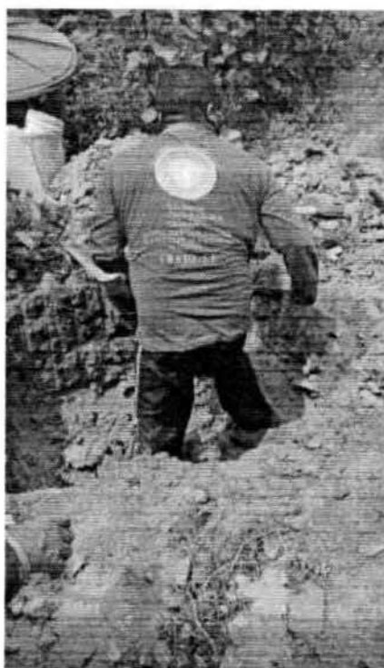
FOTO 2 – FASE DE REGULARIZAÇÃO DA VALA MAIOR
